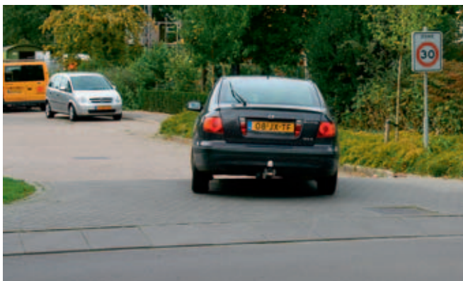
Een kruising met een inritconstructie naar een woonwijk
